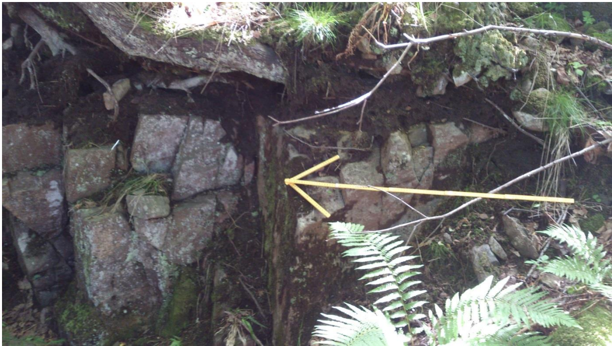
Figur 1 Bilden visar sprickzonen i bergskärningen vid område 3, foto taget mot öst.
